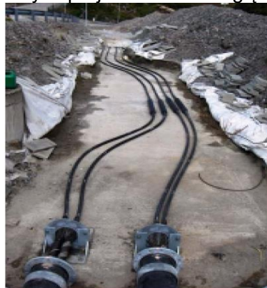
Rysunek 3-4: Blok pancerza w kanale na mufę przejściową pomiędzy częścią morską a lądowa [16]
