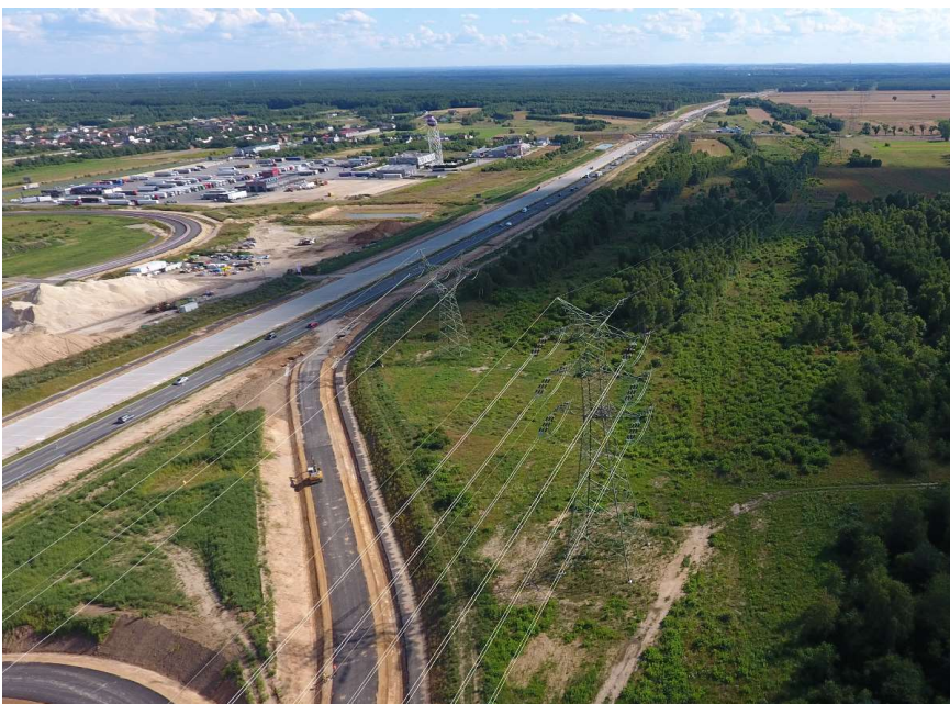
Rys. 2. Słupy linii 220 kV i 400 kV dla usunięcia kolizji przy węźle autostradowym zostały wymienione na wyższe.
