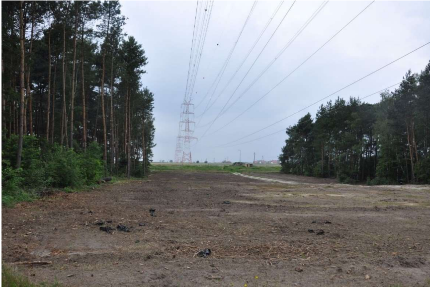
Rys. 1. Korytarz czterotorowej linii elektroenergetycznej 2x400 kV/1x220 kV/1x110 kV.
